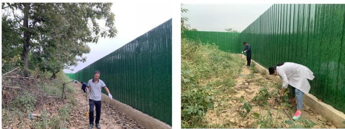
图 2.5-10 现场勘测照片
